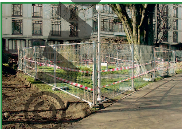
Gedeeltelijke bescherming van stam en boom. Rijplaten op plaatsen waar geen omheining mogelijk is.
